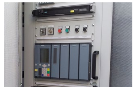
Steuerschränke Siprotec 5
